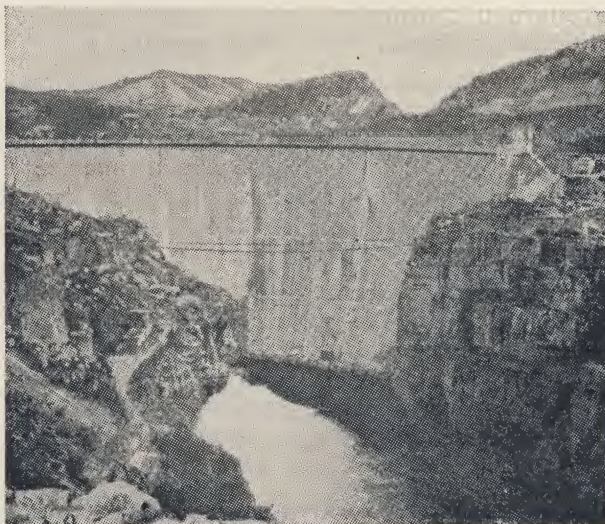
Sl. 16: Betonska lučna brana Dokan na rijeci Zab
